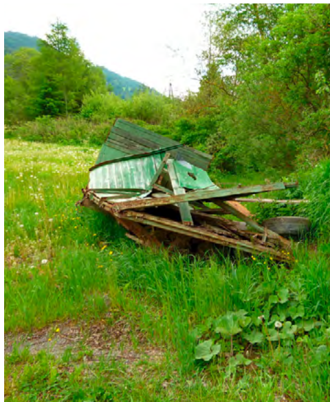
Trümmer des Toiletten-/Duschwagens auf dem alten Platz.
